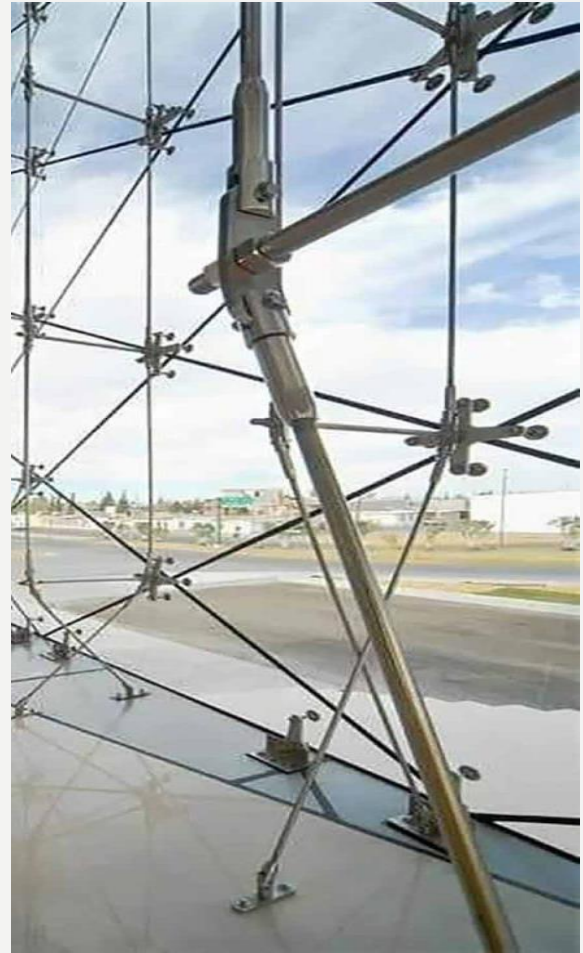
نمای اسپایدر کابلی
