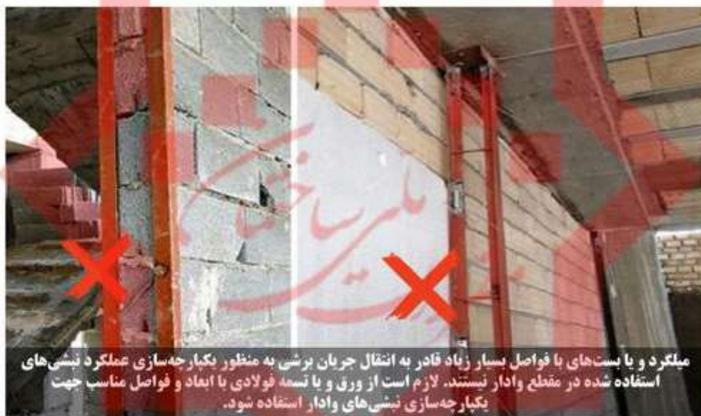
شکل پ-۶-۷ ایراد متداول مربوط به بست‌های مورد نیاز جهت یکپارچه‌سازی مقطع وادار
