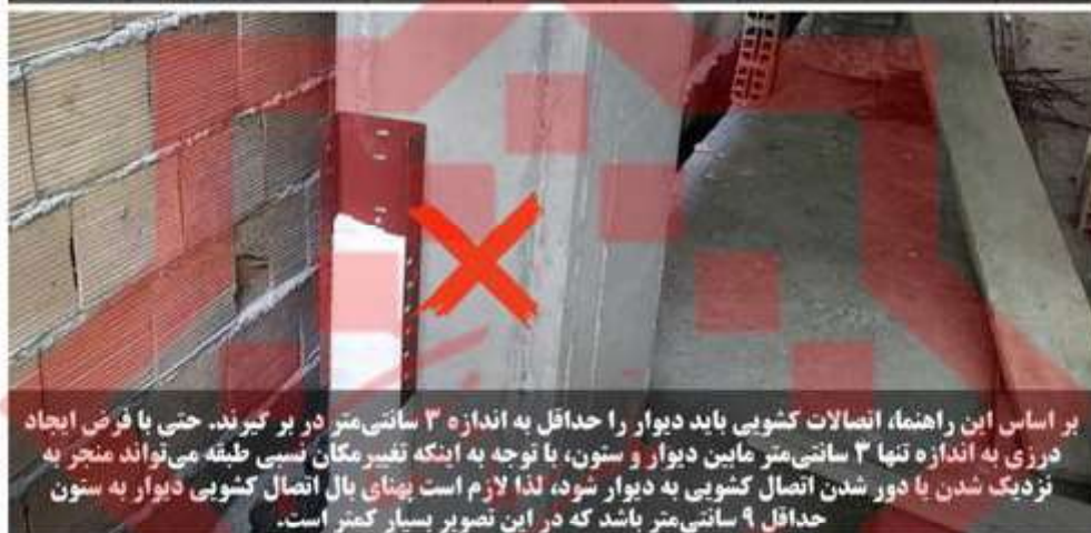
شکل پ-۱-۷ ایرادات متداول ناکافی بودن پهنای بال در اتصالات کشویی دیوار به سقف و دیوار به ستون.
