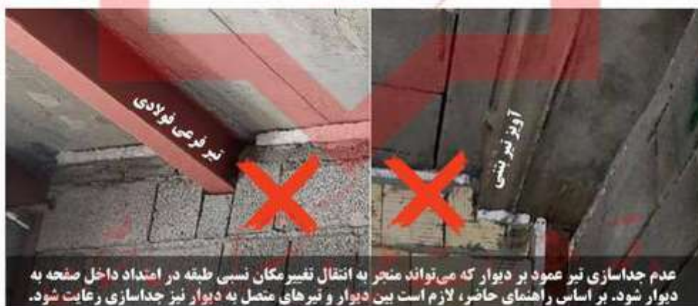
شکل پ-۲-۷ ایراد متداول عدم جداسازی بین تیر و دیوار.
