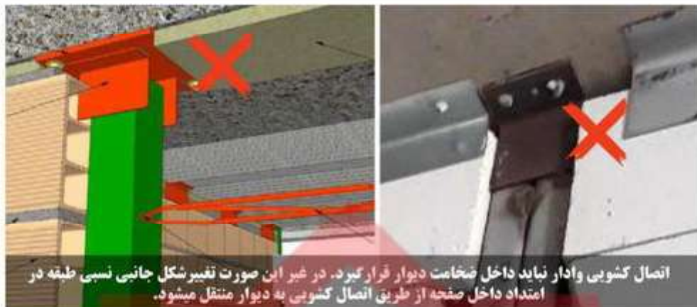
شکل پ-۵-۷ ایراد متداول مربوط به قرارگیری اتصال کشویی وادار در داخل ضخامت دیوار.
